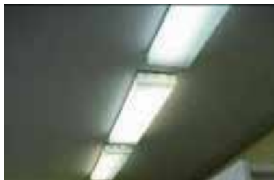
Slika 49: Fluo lampe sa magnetnom prigušnicom
