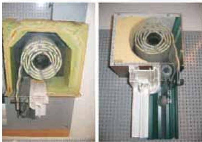
Slika 27: Slika pravilno toplotno izolovane kutije za roletnu
